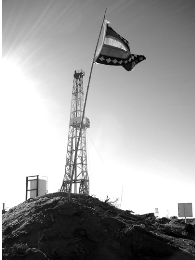
Perforación de pozo de gas en Gelay Ko 1.
